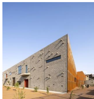
پروژه ساختمان تجاری ارغنون
