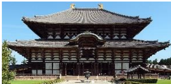
شکل ۷. مفهوم نیروی بازگرداننده در تالار بزرگ بودا که با استفاده از وزن زیاد سقف، سازه را به حالت اولیه بازمی‌گرداند (Okubo, 2016). این عملکرد بر اساس تعادل بلوکی (Mendes, 2015) قابل اثبات است.
