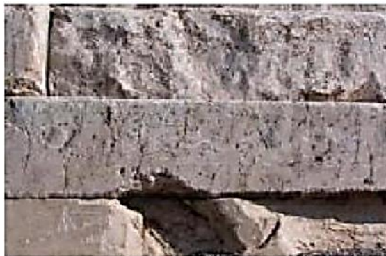
شکل ۱. آرامگاه کوروش کبیر و نمای نزدیک از لایه‌های سنگی بدون ملات که نقش جداساز لرزه‌ای را ایفا می‌کنند (Bayraktar et al., 2012).
